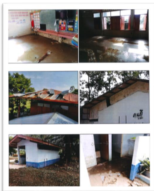
ภาพก่อนปรับปรุง
